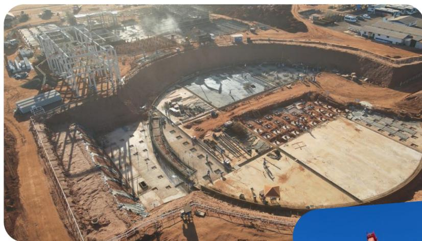
Atualmente, cinco empresas fornecem a mistura para as estruturas de base da fábrica. Parte é moldada no próprio local. Outra parte – o que inclui vigas, pilares e lajes, por exemplo – é pré-moldada em usinas de concreto, com a ajuda de formas e técnicas de cura para dar maior resistência ao material depois de seco.
