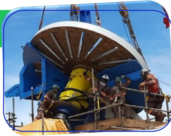
Esse equipamento reduz a madeira já cortada em forma de toras a pequenos pedaços padronizados, chamados de cavacos, prontos para o estágio seguinte na produção da celulose, o cozimento.
