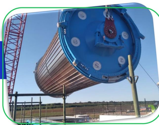
Justificando a grandeza da fábrica, quatro deles são os **maiores tambores já produzidos para o setor**. Cada um mede 5,5 metros de diâmetro por 11 de comprimento e pesa 146 toneladas. É praticamente o peso de uma locomotiva diesel-elétrica.
